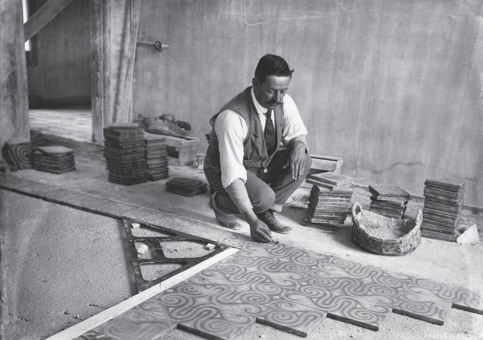
Treballs d'alineació i col·locació de rajoles de mosaic hidràulic.
